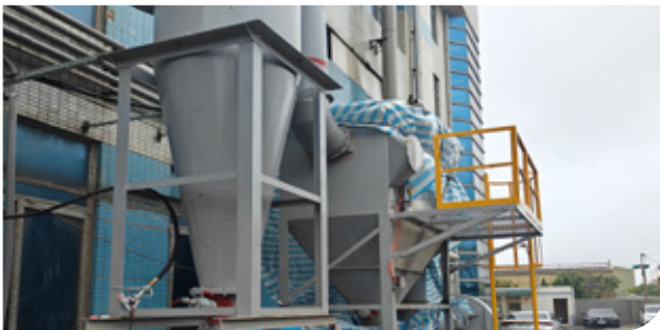
空污防制設備 --8 台集塵機整合
