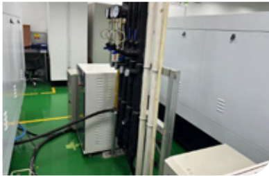
鑽孔機風冷冷卻改為中央冰水
